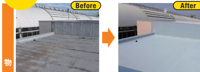
物件例1 販売前に屋上防水工事を実施し投資家の修繕負担を軽減。
